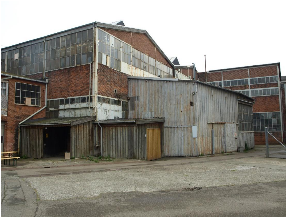
Hal 16 med tilbygninger i træ i forskellige størrelser.
