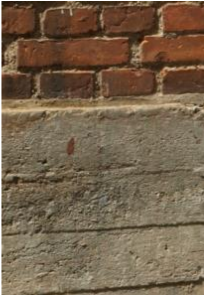
Kraftig sokkel i støbt beton, med synligt aftryk af brædeforskalling, danner flot kontrast til de røde
