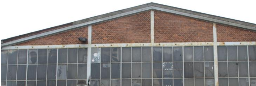
Synlig stålkonstruktion, røde teglsten og stort vinduesbånd i hal 17.
