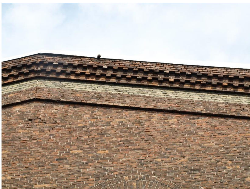
Fine detaljer i facaden af hal 14: muret stik over vinduet, aftrappet gesims og frise med rød og gul murstensbånd.
