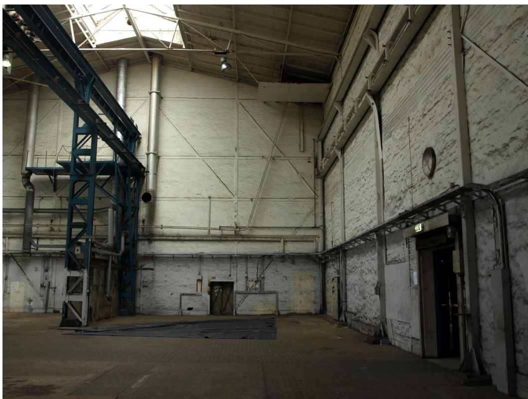
Hal 16, ombygget i 1944 efter brand, viser sin bindingsværkslignende konstruktion i væggen mod hal 17 og hal 19.
