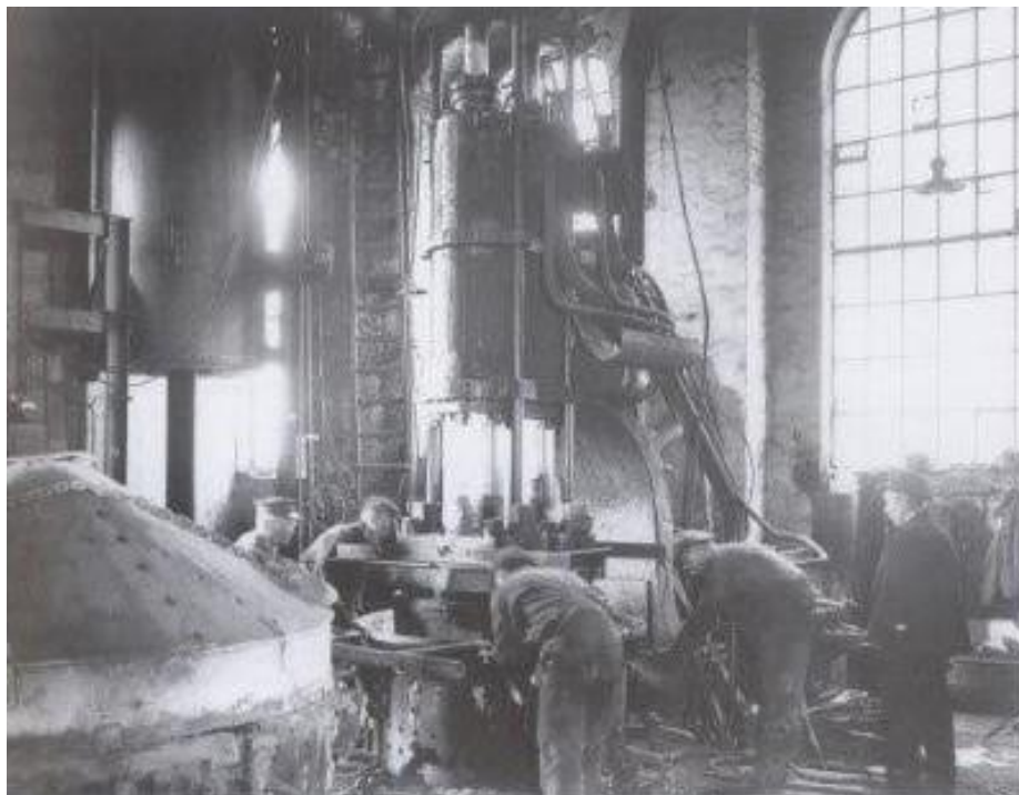
Kedelsmedien havde god plads og højde i hal 17. Hallen var tegnet af Johannes Emil Gnudtzmann, med karakteristiske høje vinduer, som også kan ses i hal 14, 18 og 16. Hal 17 blev kraftigt ombygget i 1944 efter brand. Kilde: Pedersen, 1982.
