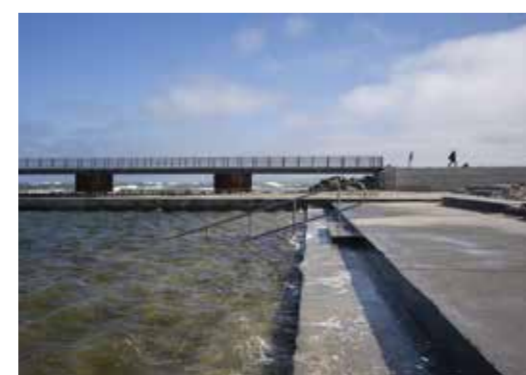
Promenadekant som klimatilpasning. Foto | Nørre Vorupør Havnebad | SLA Foto - modstående side | Nørre Vorupør Havnebad | SLA
